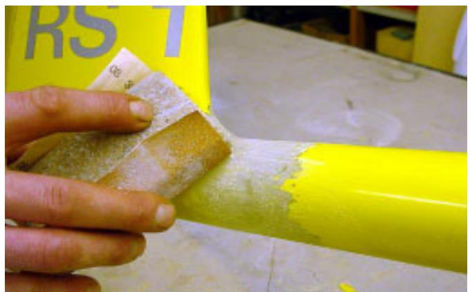
Nach der Härtung wird die Reparaturstelle vorerst mit einer Zinnraspel (Spengler- oder Klempnerbedarf) grob geschlichtet und mit Schleifpapier geschliffen.
